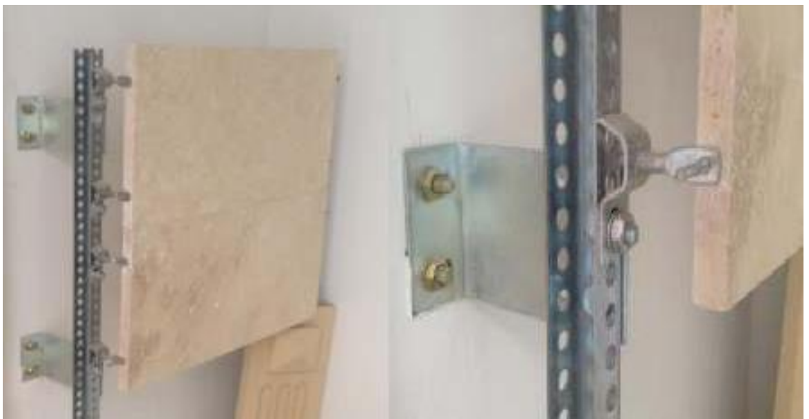
2-сурет Табиғи тасты бекітудің профильді жүйесі.
