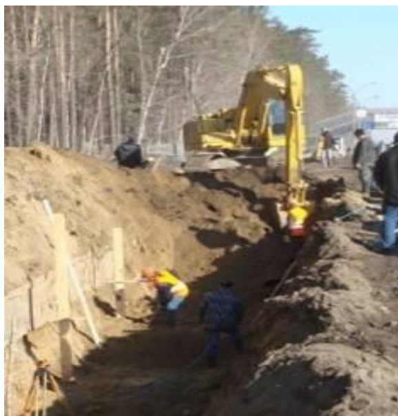
Сурет 1. Кері қазғыш экскаватормен ор қазу
