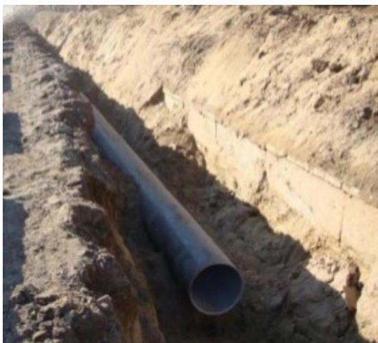
Сурет 2. Полиэтилен құбыры орда
